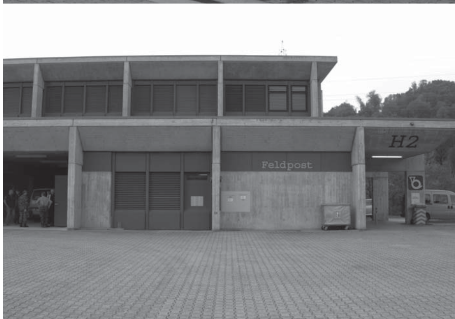
Das neue Postbüro
